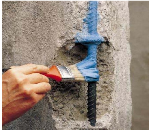
Рис. 3. Нанесення однокомпонентного порошкового водорозчинного складу на основі цементу та інгібітору корозії
