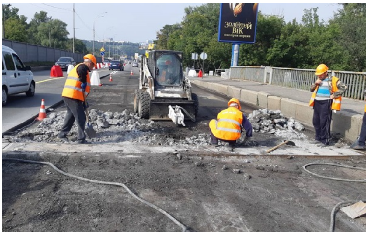
Рис. 1. Ремонт бетонної плити на мості з високим навантаженням
