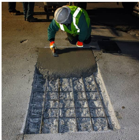
Рис. 4. Завершальний етап відновлення із застосуванням полімерцементного розчину
