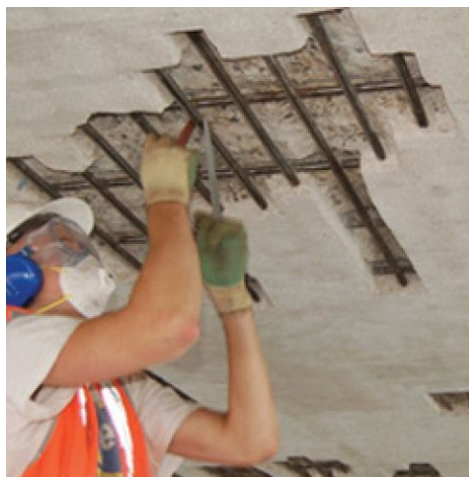
Рис. 2. Механічне очищення арматури від іржі смужкою шліфувального паперу
